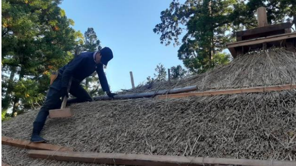
<茅葺き屋根 葺き替え作業の様子>
