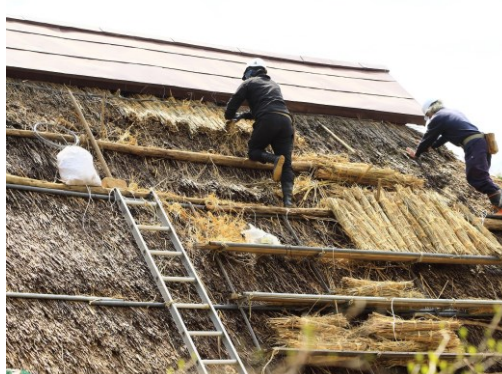
★4 月、おやけ棟の屋根修復
