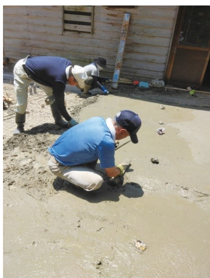
建物周辺のコンクリ工事は全て自分たちで行います。集落のベテランに応援を頼むことも。
