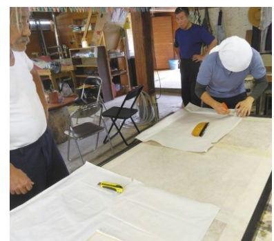
若手スタッフの技術向上を図って内装のふすまの張替え練習中。湿気と張りムラに気を付けながら1枚1枚丁寧に張っていきます。
